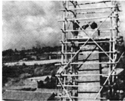
図3-6 新築煙突作業風景（山本組）
