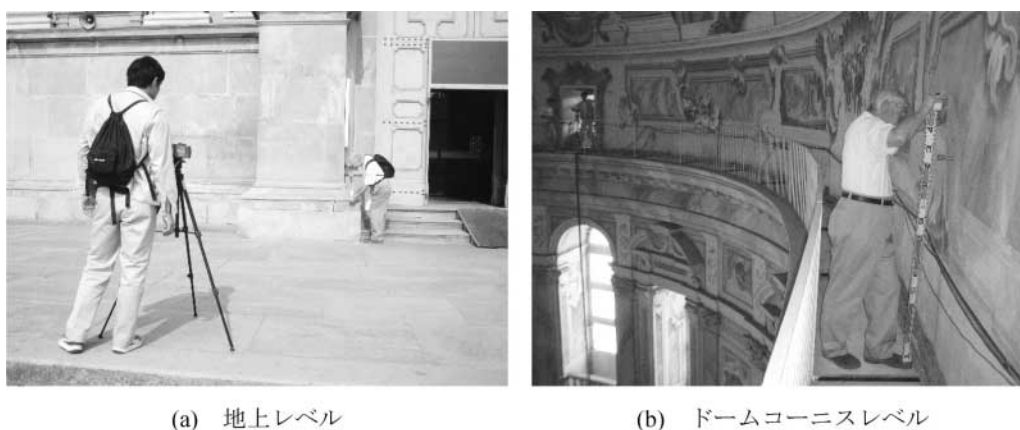
図2-26 レーザ距離計を用いた不同沈下調査状況
