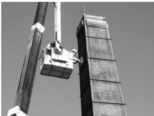
(a) 厚さ測定状況
