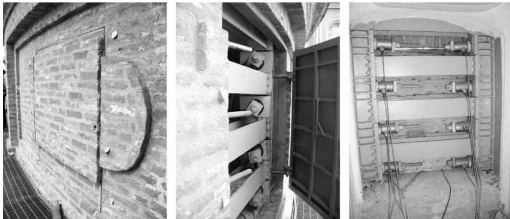
(a) 外観（扉） (b) ポストテンションリング (c) ジャッキシステム
