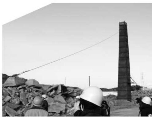
(d) 静的崩壊実験状況
