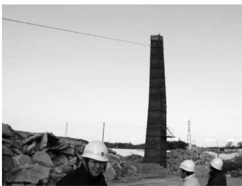
(e) 中央部の亀裂発生状況
