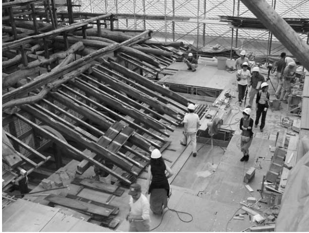
写真 2-1 古建築の改修木工事見学会(名古屋市長東区)
