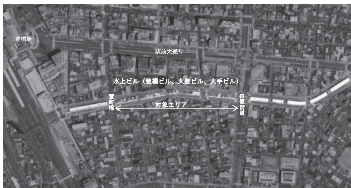
図1 水上ビル航空写真
