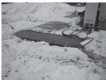
図4. 小規模融雪システムの施工状況
