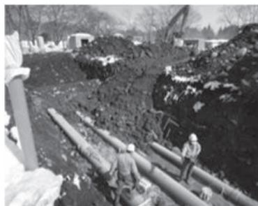
図2. 水平展開式地中熱利用システム(ジオプロムナード)の施工状況
