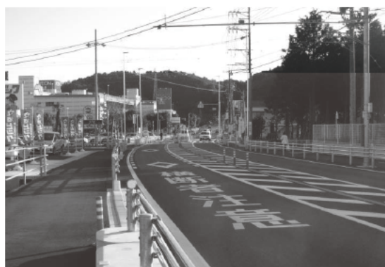
写真1. 関市倉知の二段階横断施設の上流区間
