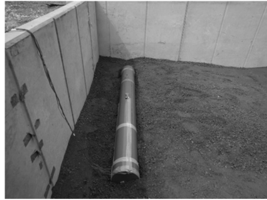
(b) 埋設管設置状況
