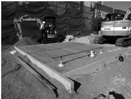
(c) ジオシンセティクス敷設状況
